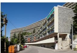
8. Luigi Carlo Daneri (e altri) / Complesso residenziale Forte Quezzi, Genova, 1956-57
