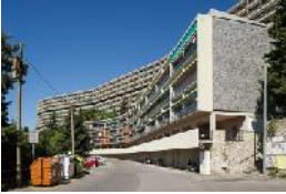
9. Luigi Carlo Daneri (e altri) / Complesso residenziale Forte Quezzi, Genova, 1956-57
