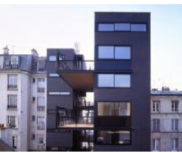
29. Philippe Gazeau / appartamenti per impiegati delle Poste in Rue de l'Ourcq, Parigi, 1993
