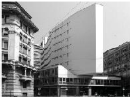
4. Luigi Moretti / Complesso per uffici e abitazioni a Corso Italia, Milano, 1949
